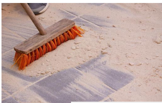
Aplicarea nisipului, nisipului-ciment pentru rosturi
