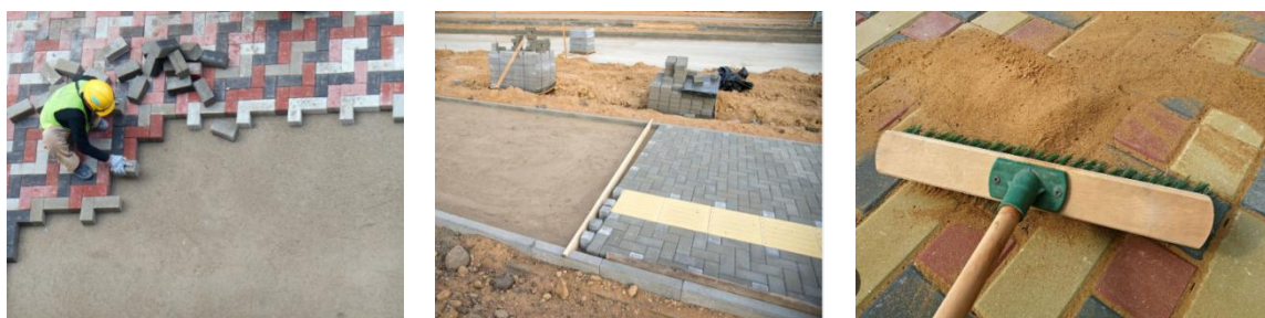
Așezarea pavelelor, umplerea rosturilor
