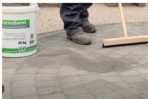
Aplicarea nisipului, nisipului-ciment pentru rosturi
