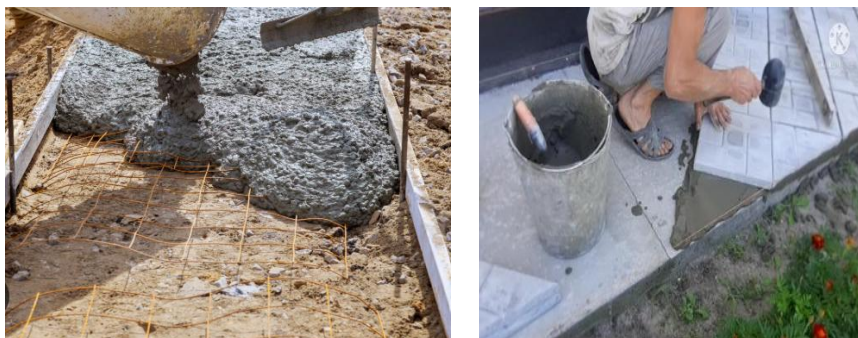
Montarea pavelelor pe beton
