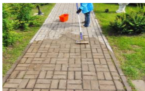
Aplicarea vopselilor impermeabile
