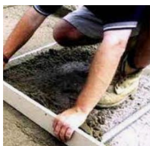
Lucrări de nivelare a terenului
